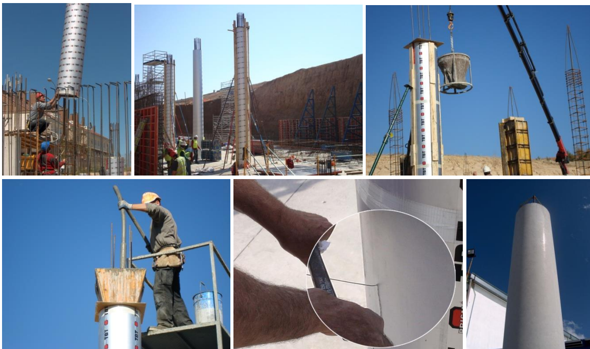
Figura 2. Puesta en obra de encofrados TBT.
